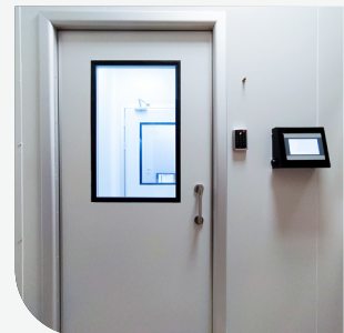
Temiz Oda Kapısı
